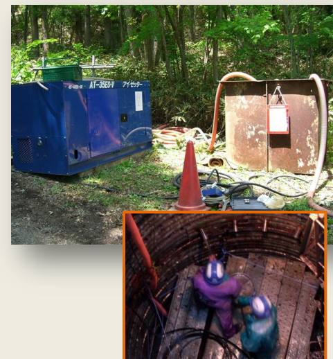
▼集水管鋼管洗浄
